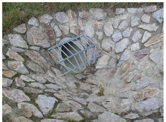
Bild 11: Aufnahme Durchlass in Kanal.
