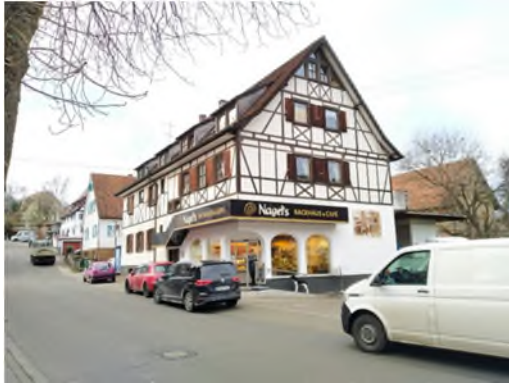
Foto 1: Backhaus Nagel in der Ortsmitte von Ostelsheim
